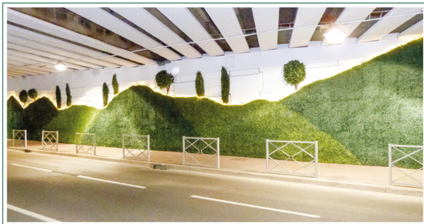
TUNNEL MAIRIE Cagnes sur mer
