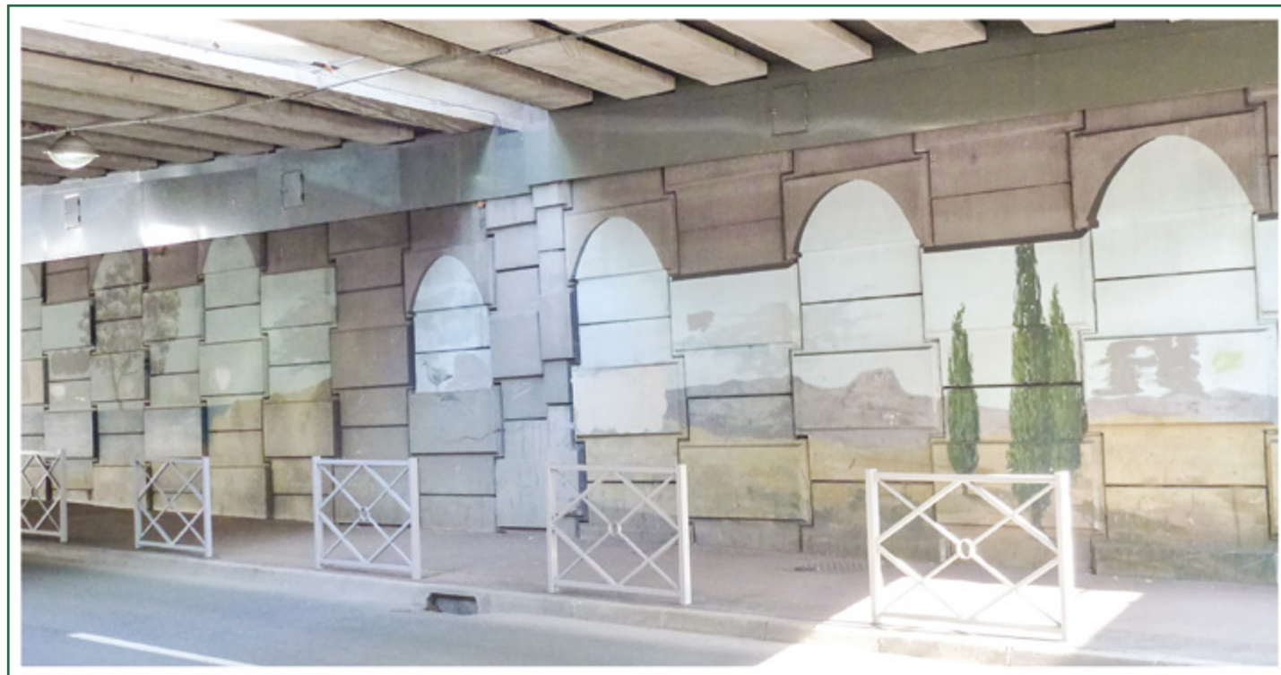
TUNNEL MAIRIE Cagnes sur mer
